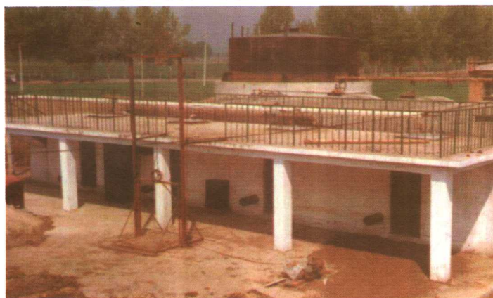
彩图 22.5 4 \times 100\text{m}^3 中温发酵沼气池, 日处理厩粪 6t
