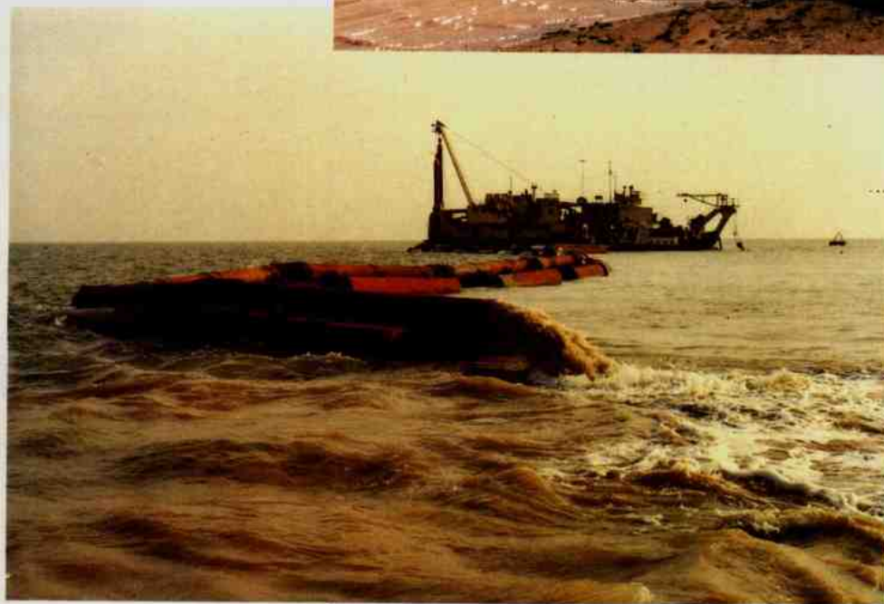
吸泥船在黄河口施工
