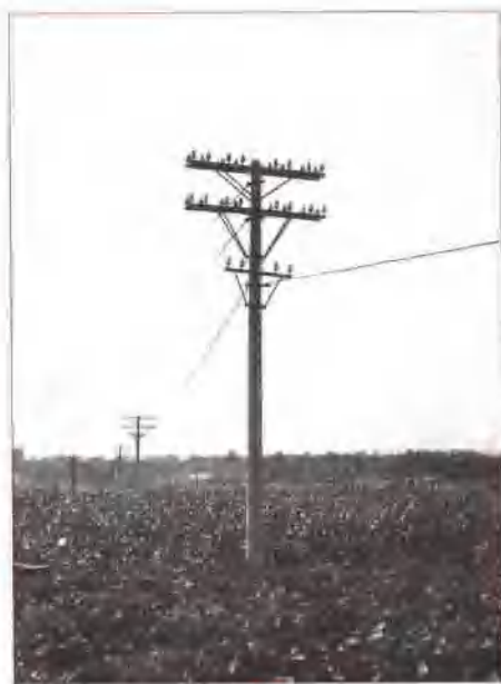
至翟镇方向的水泥杆路 (1979)
