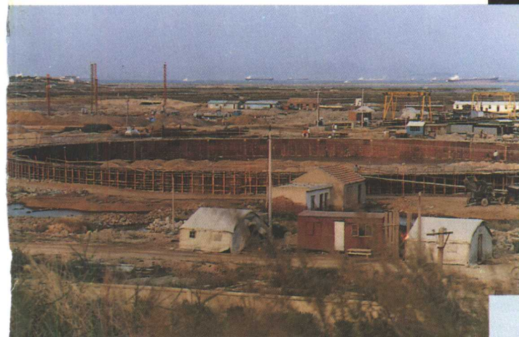
建设中的40万吨新油库
