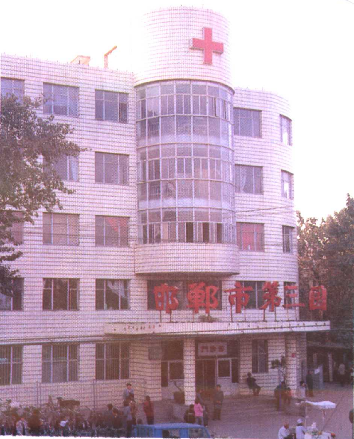
市第三医院门诊楼
