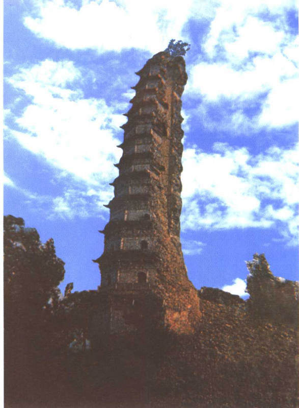
半壁坍塌的法门寺明代真身宝塔
