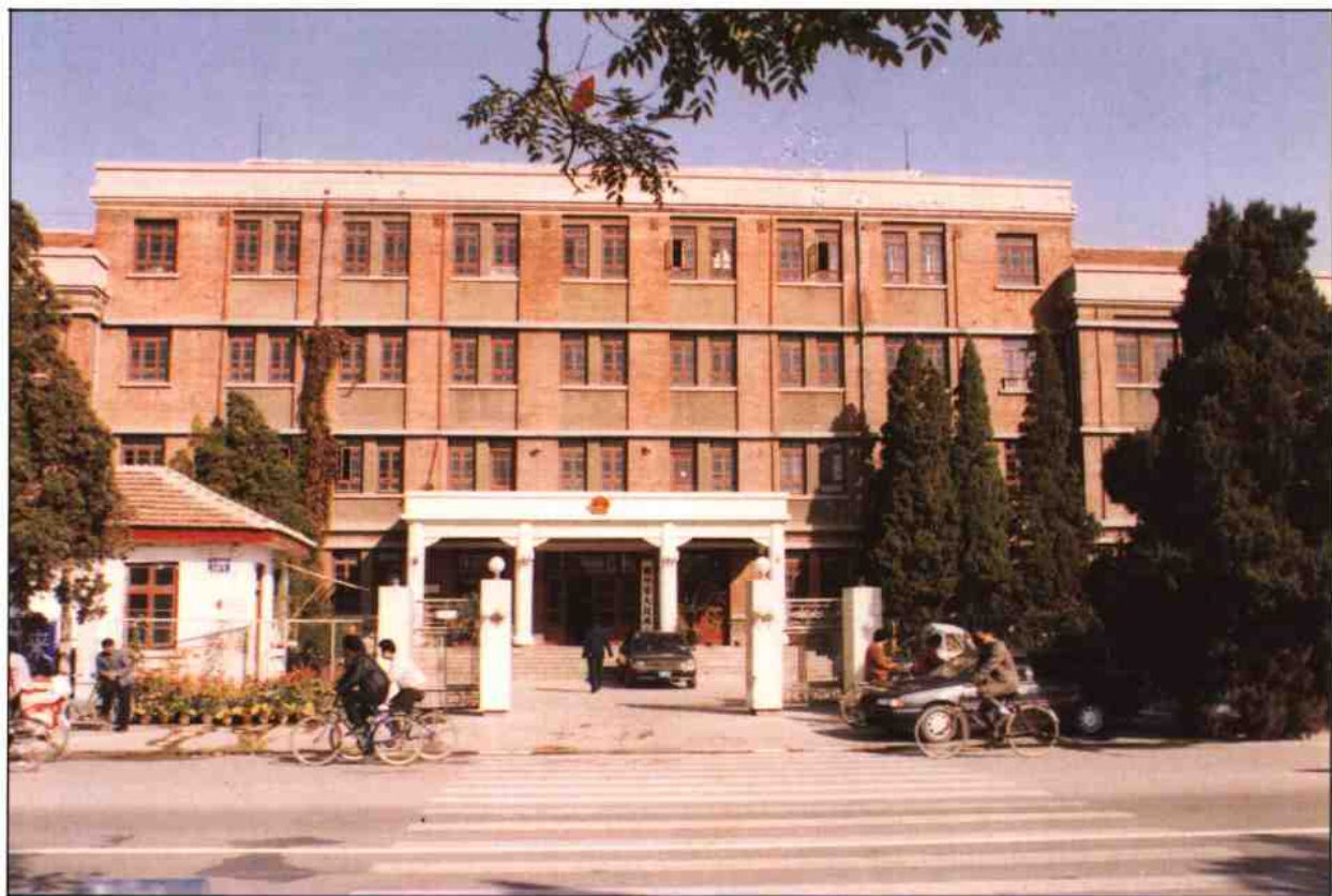
德州市人民政府办公楼
