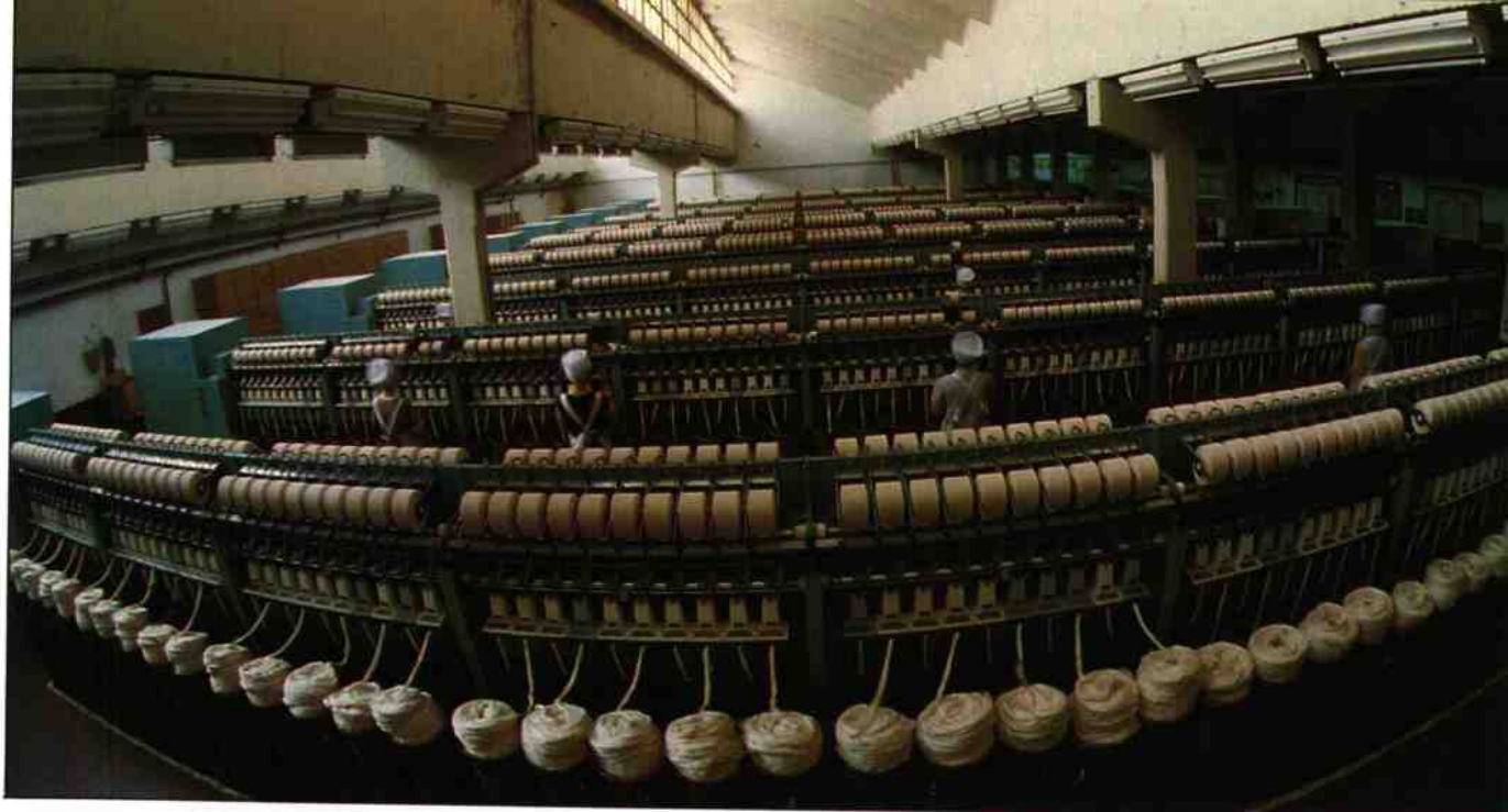
德州棉纺织厂气流纺织车间一角
