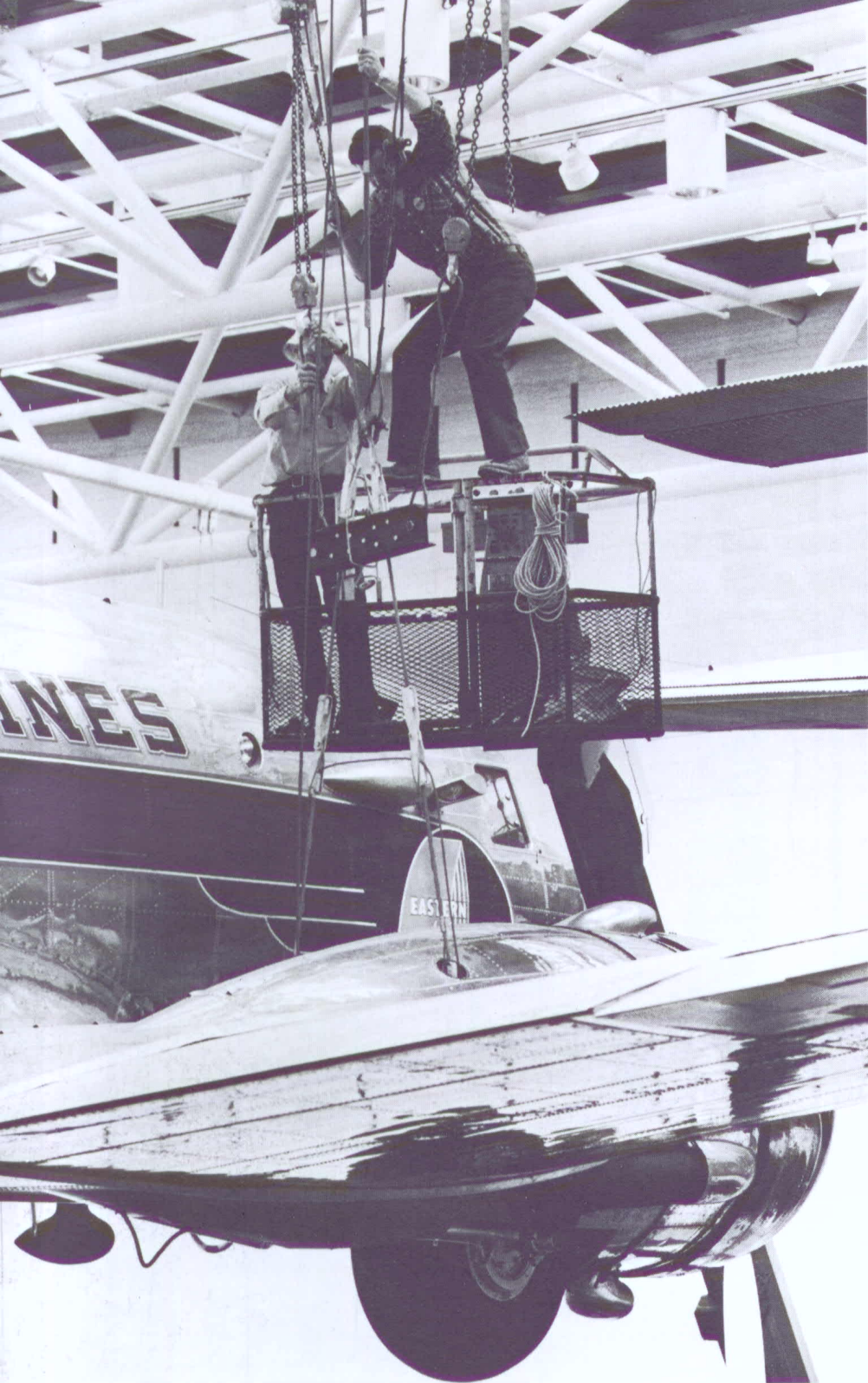
(左圖) 展示機的檢查工作 該館的展示機，經常進行細心的保養並詳加檢查。圖中正在做抽換展示機的懸掛鋼索工作，以策安全。
