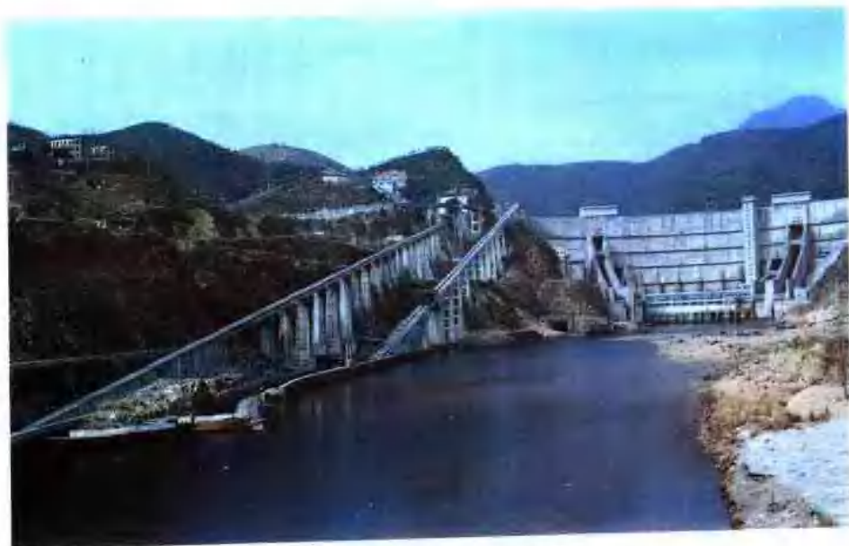
紧水滩水电站坝区船排道(船舶过坝)
