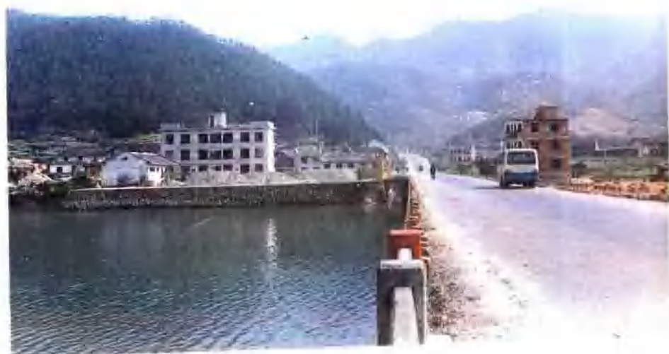
汽车行驶在加筋上路堤上
