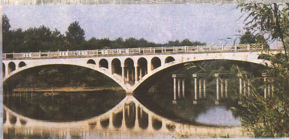
东鱼河北支保宁双曲拱桥
