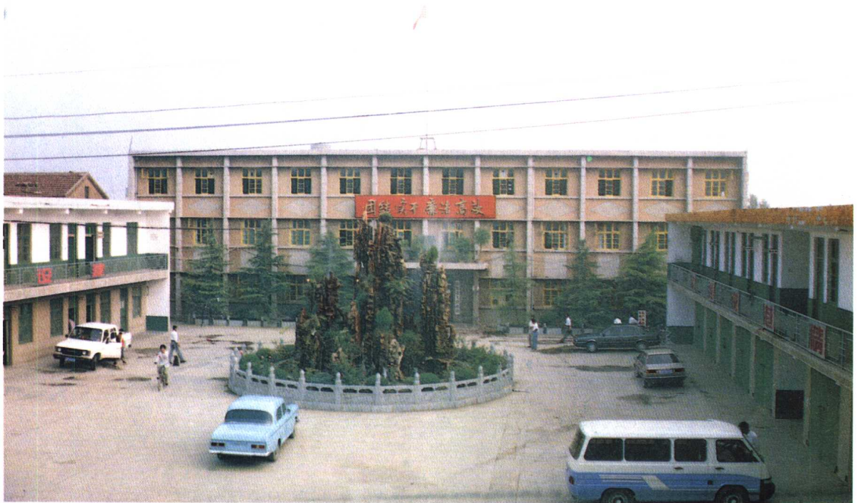
巨野县人民政府办公楼
