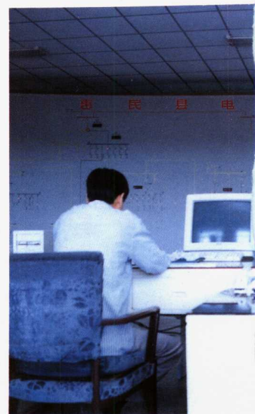
惠民县电业局调度室
