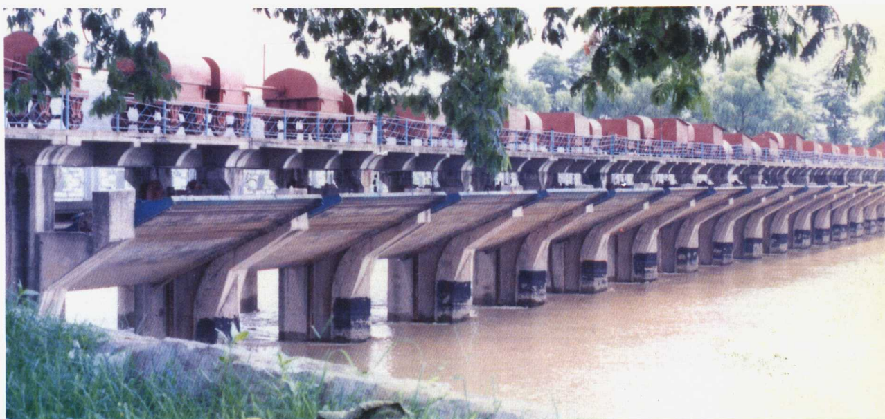
樊家桥 栏河闸
