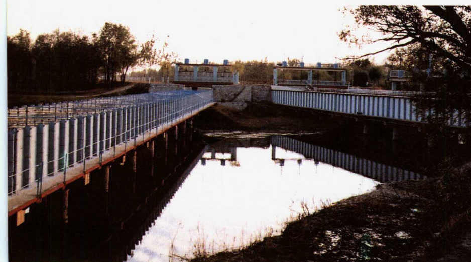
小杨村东“鸳鸯渡槽”
