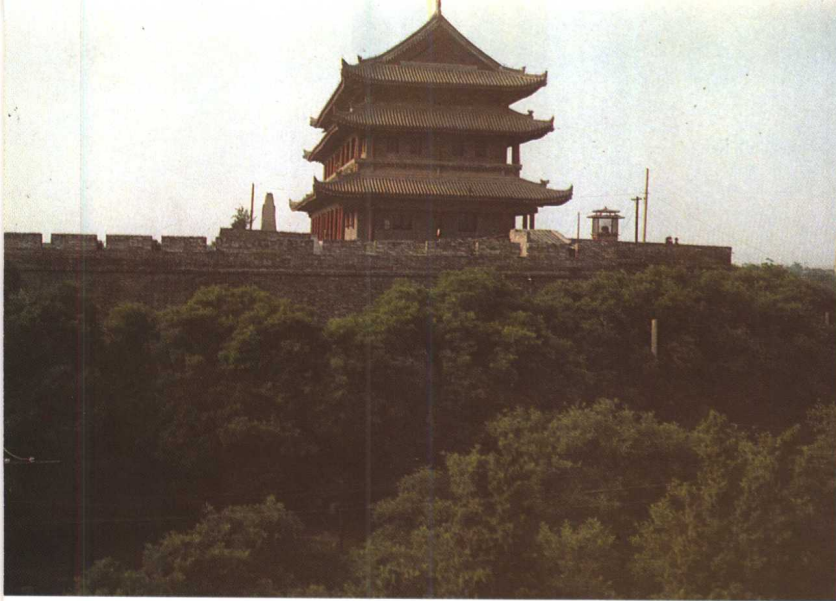
▲西安西城门安定门的正楼
