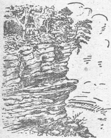
图3. 植物的根对岩石的破坏作用。
