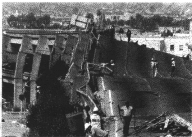
图 1 地震引起桥梁倒塌
