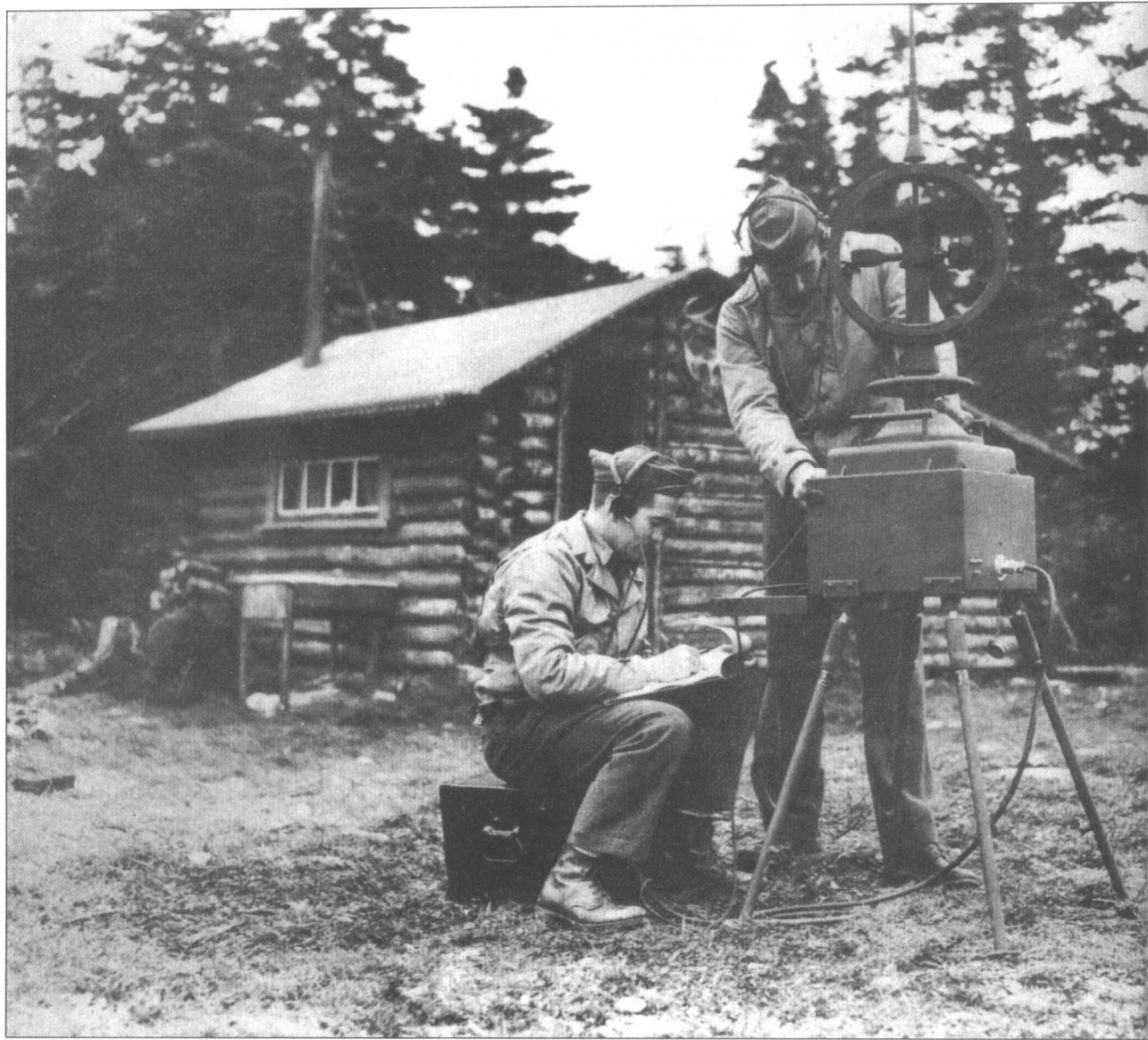
在纽芬兰的两名士兵通过一台无线电指示器来监控信号，追踪正在沿着大西洋护卫路线航行的船和飞机的行踪。
