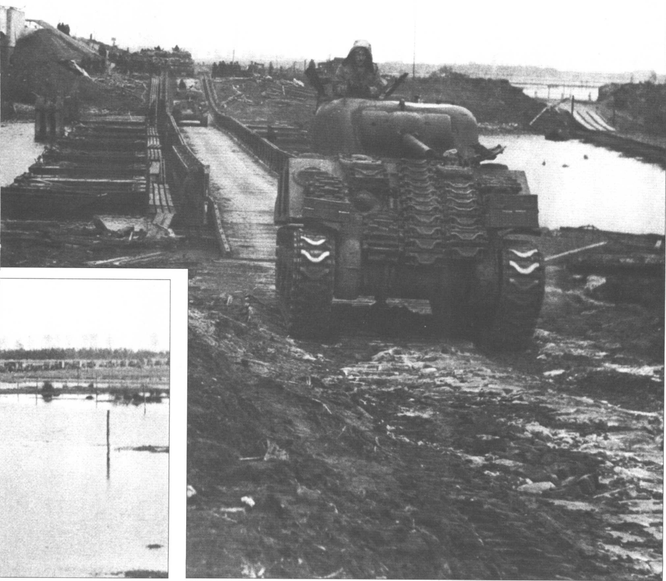
后来,坦克通过了浮桥。旁边是德军撤退时被炸毁的吊桥,已无法使用。
