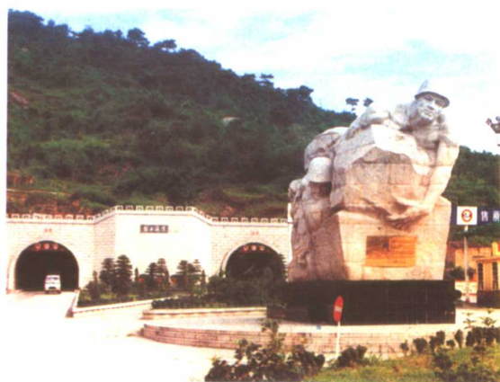
由驻闽部队支援建设的鼓山隧道
