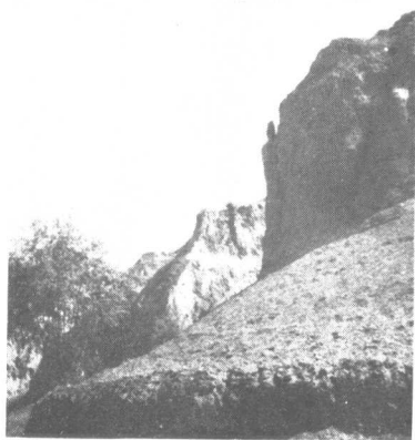
照片15 崩塌侵蝕,即將下塌的土柱(綏德)
