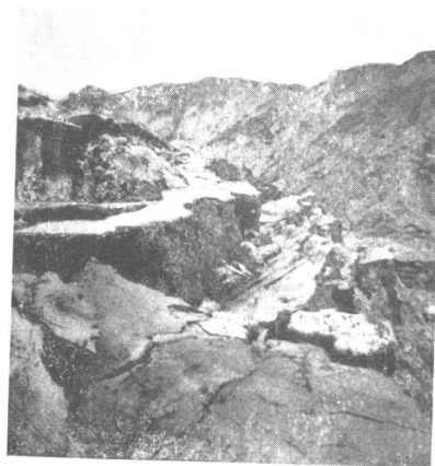
照片14 滑塌侵蝕(紅柳河石窩溝)
