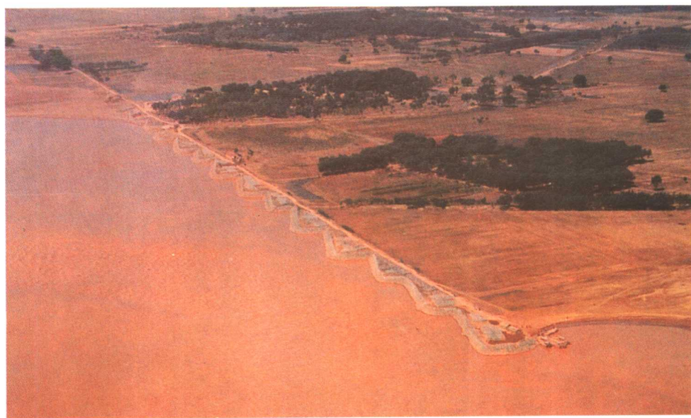
▷ 为调处黄河密城湾水事纠纷而修筑的马张庄控导工程
