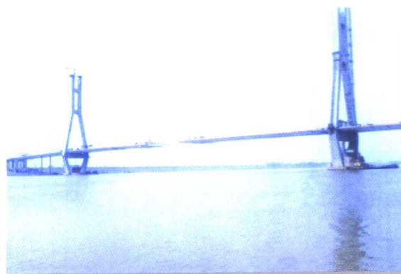
武船用 14 个月的周期, 完成了京珠高速公路武汉军山长江大桥全部钢箱梁、节段制造任务
