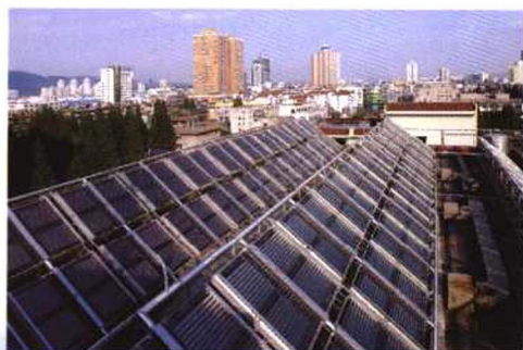
南京老城区 60 平方公里范围内“禁燃区”4 吨以下燃煤锅炉已基本完成使用清洁能源改造。图为和园饭店的太阳能与燃油锅炉的联动供热方式
