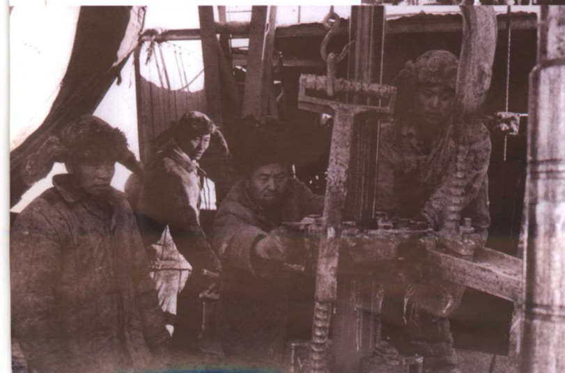
大庆油田的开采，迈开了我国自力更生发展石油工业的第一步。图为石油工人的杰出代表“铁人”王进喜在生产第一线。（下图）
