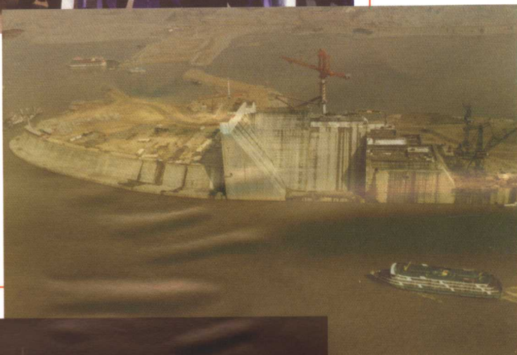
船只通过三峡工程导流明渠（近景）。图中部为纵向围堰的坝体，它建在长江中的孤岛——中堡岛上，大坝建成后，它将成为大坝的一部分。（右图）
