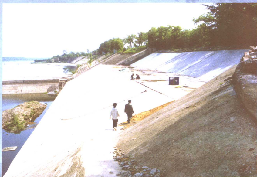
正常溢洪道一级消力池右岸护坡混凝土施工
