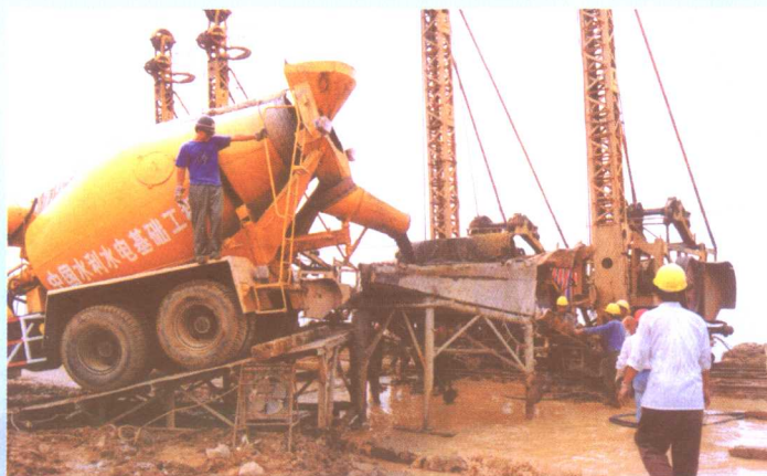
副坝防渗墙施工混凝土浇筑
