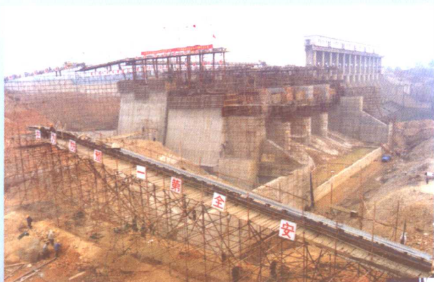
新增非常溢洪道施工
