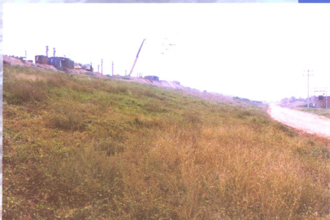
除险加固前的副坝下游坝坡
