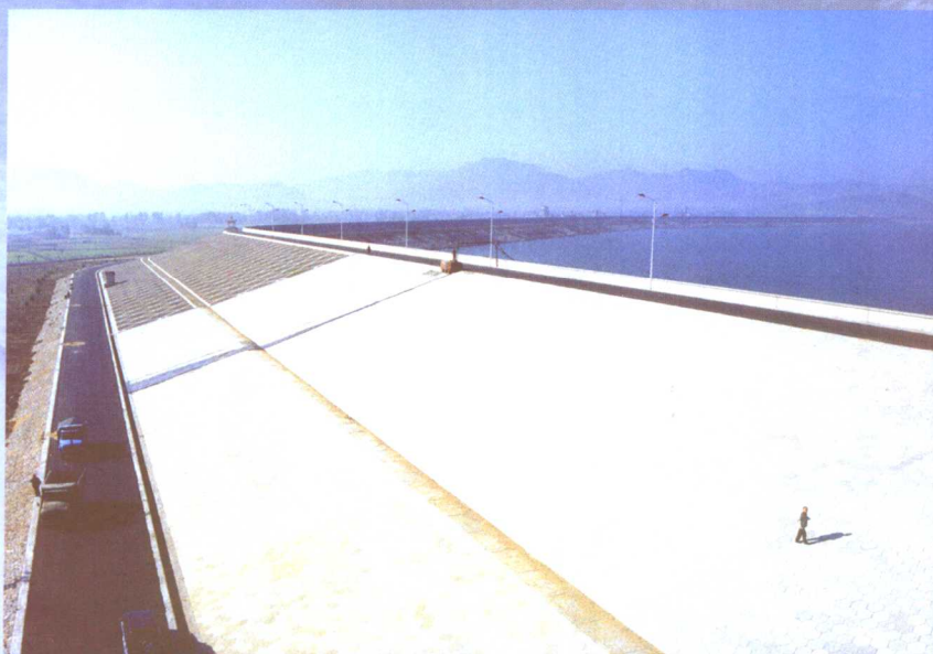
加固后的副坝
