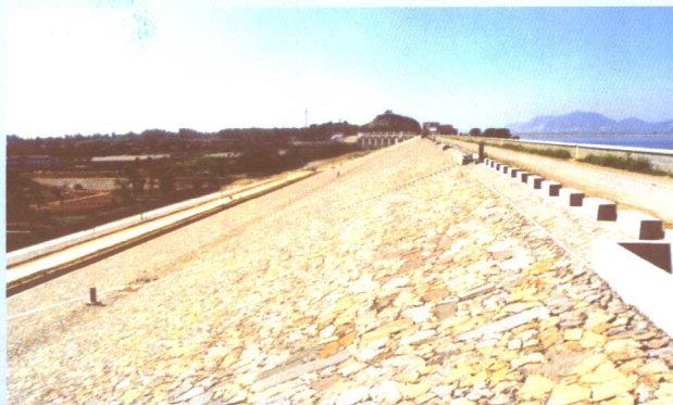
加固后的主坝
