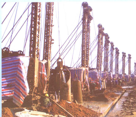
副坝防渗墙冲击钻造孔施工
