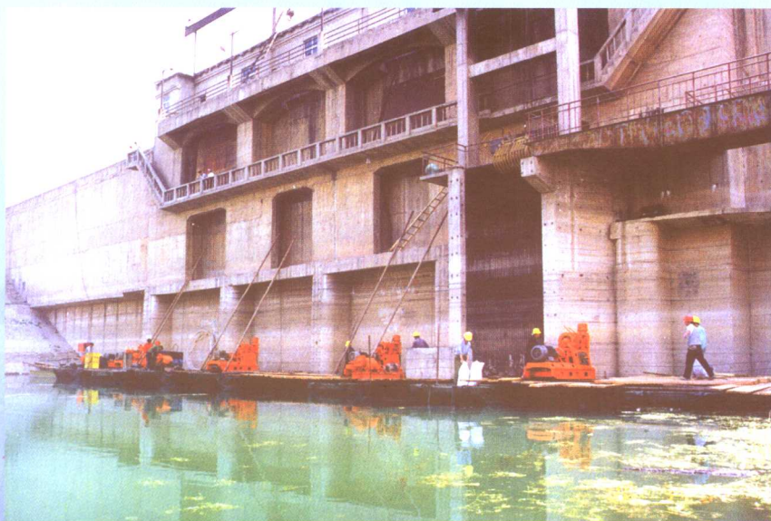
重力坝帷幕灌浆施工
