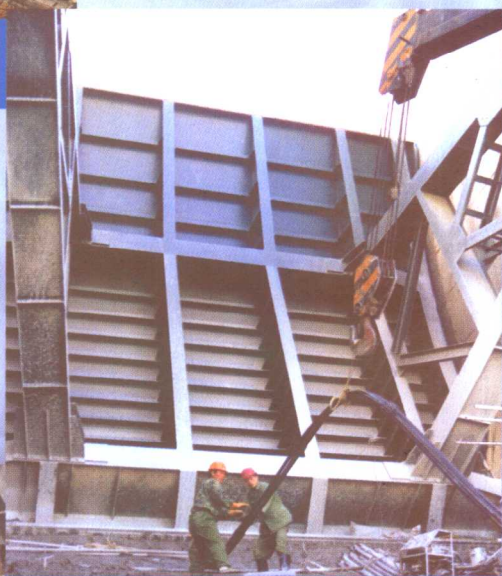
正常溢洪道预应力锚索施工
