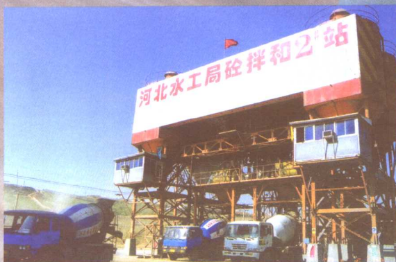
副坝防渗墙施工混凝土拌和站
