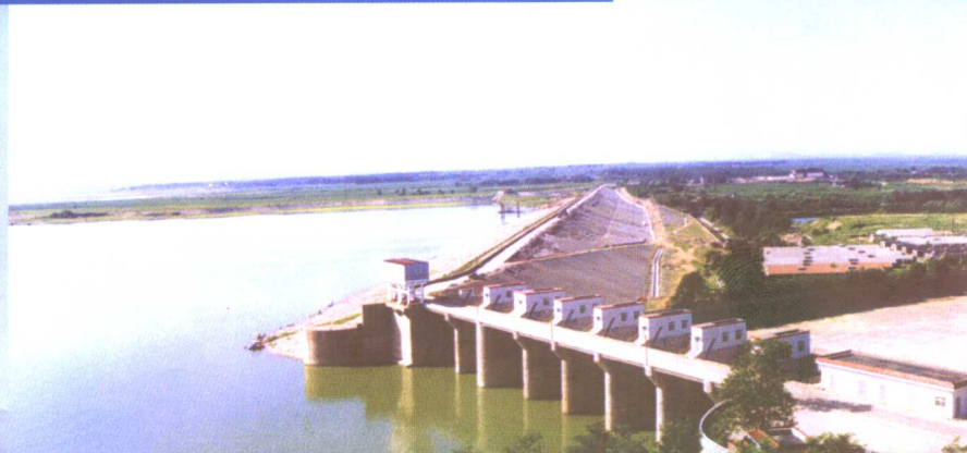
加固后的正常溢洪道与主坝
