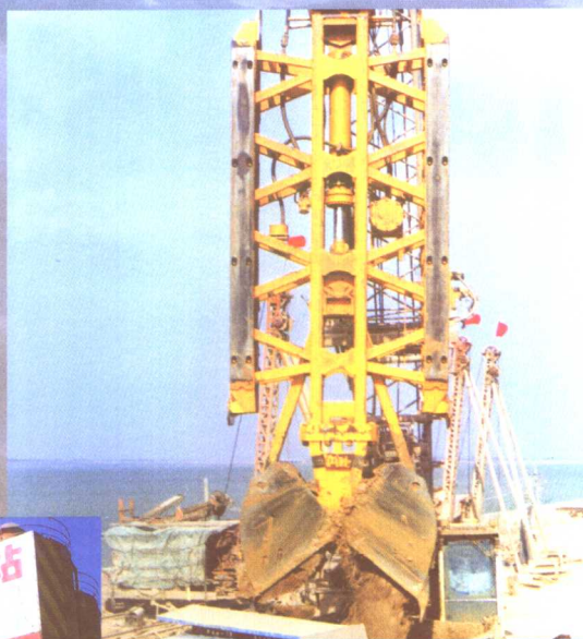
副坝防渗墙抓斗造孔施工
