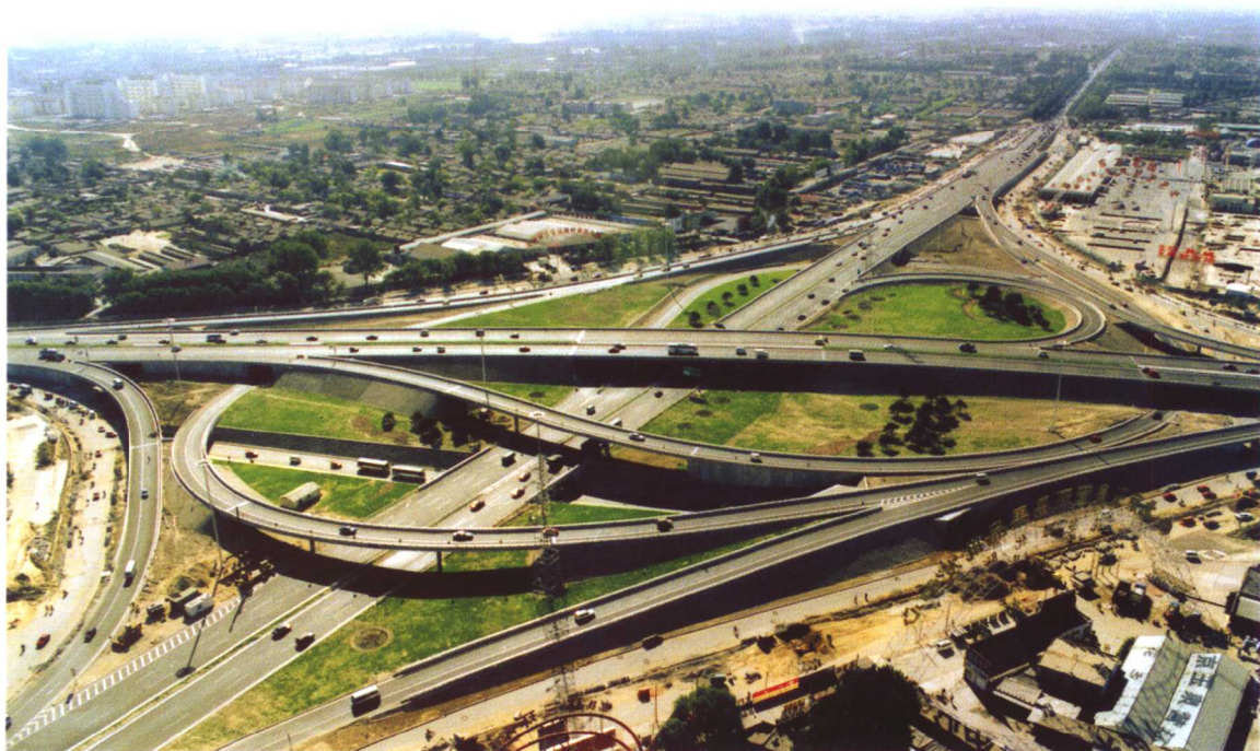
玉泉营立交桥（1999 年建成通车）
