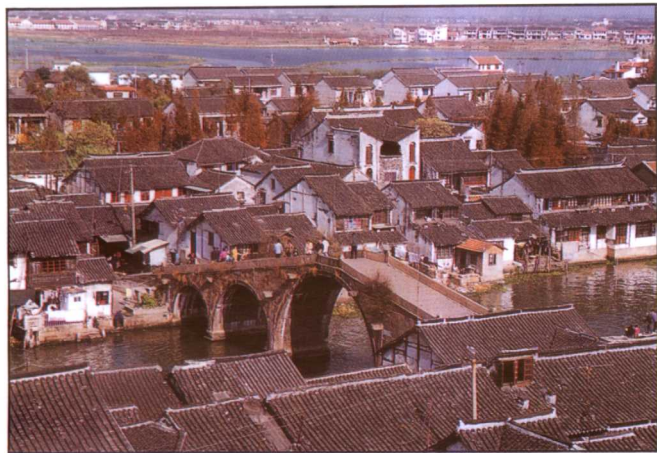
青浦县朱家角镇之一角。该镇已被列为历史文化名镇,其建设按照历史文化名镇规划的要求进行拓展和保护。照片为保护较好的该镇老区一部份,可见其粉墙青瓦的民居,树木隐掩其间,小河穿镇而过,拱桥横卧其上,一派秀丽的江南水乡特色。
