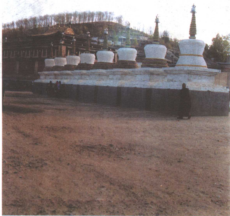
塔尔寺善逝八塔 贾鸿键摄
