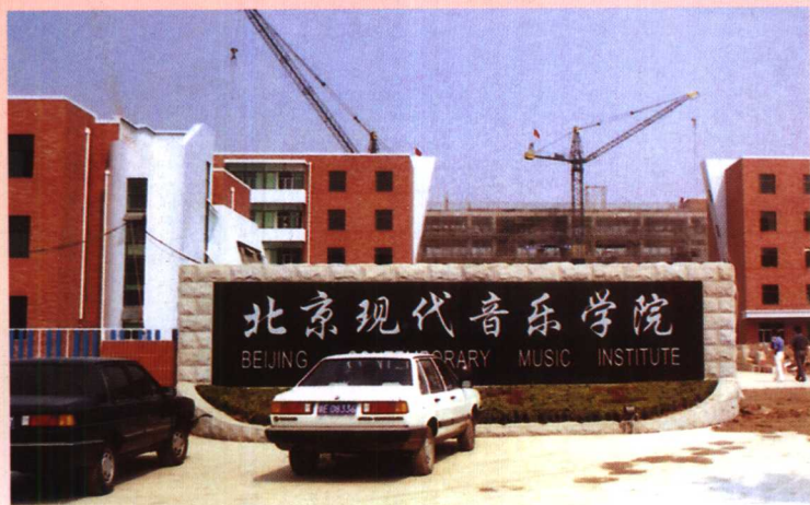
北京现代音乐学院在建设中的新校舍
