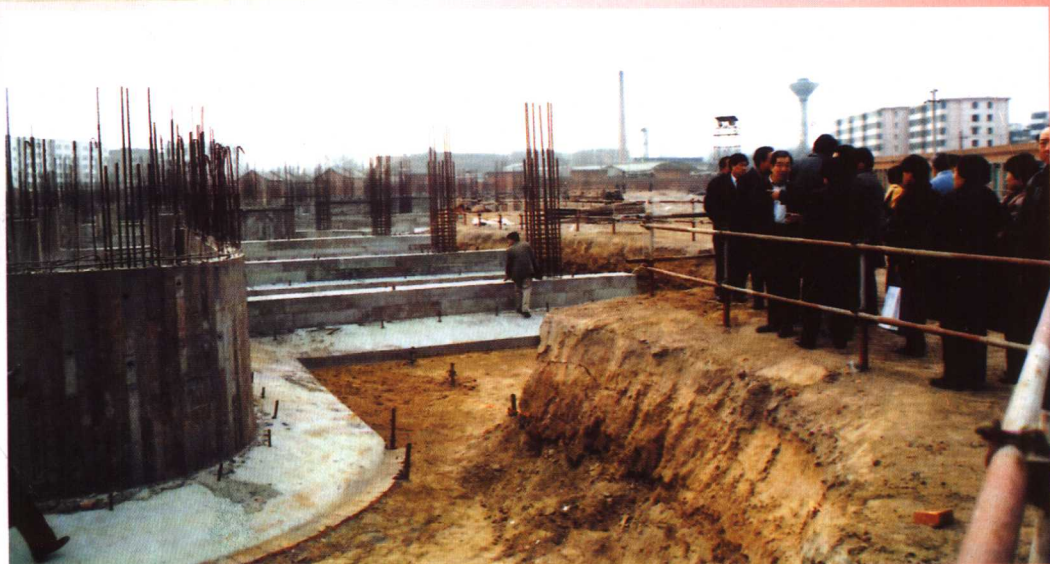
燕京华侨大学校舍工地
