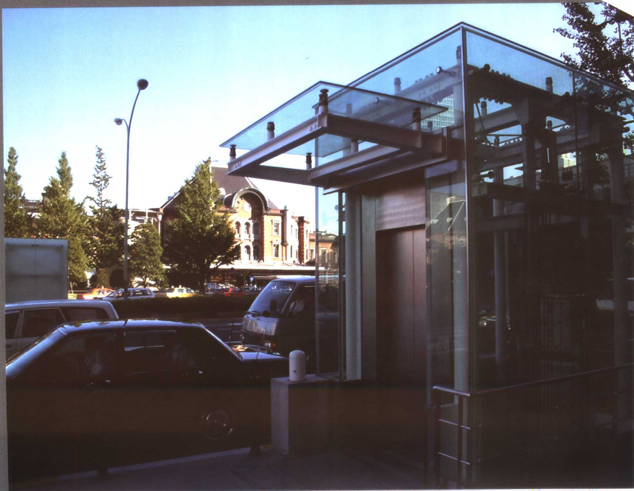
▶ 为残疾人提供的地下电梯通道
