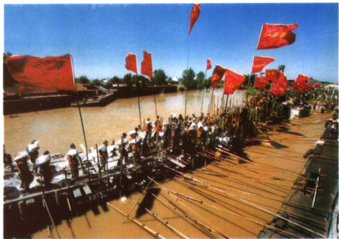
9 北京军区驻石家庄某集团军封堵决口部队222名官兵,在副军长俞森海少将带领下,采用“钢木土石组合坝”技术,在封堵九江决口中建立了奇功 新华社稿
