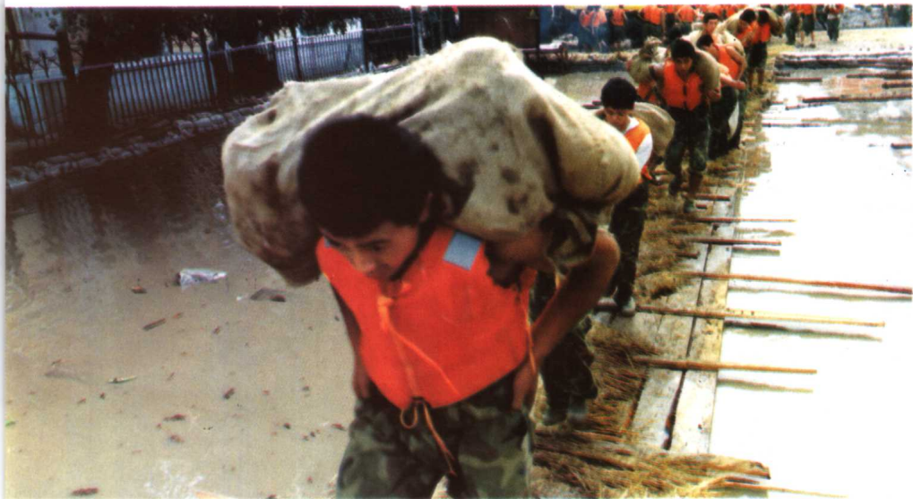
22 沈阳军区司令员梁光烈中将坐镇指挥3万多名官兵担负保卫哈尔滨突击抢险任务。 某师3000余官兵仅用12小时便在江防最薄弱的“外贸大堤”筑起一道长4000米、高 2米有余的子堤 刘铁生摄
