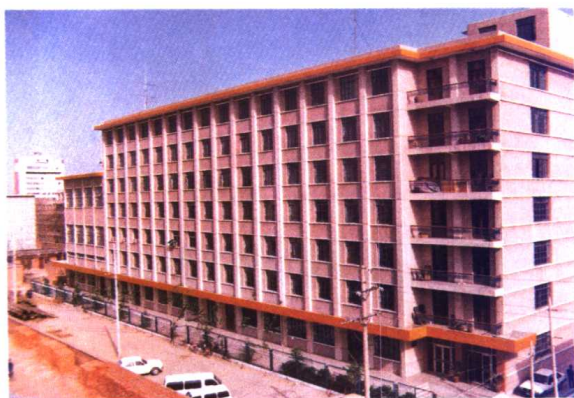
河南省工商局办公大楼。
