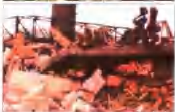
唐山大地震后残破的建筑物
