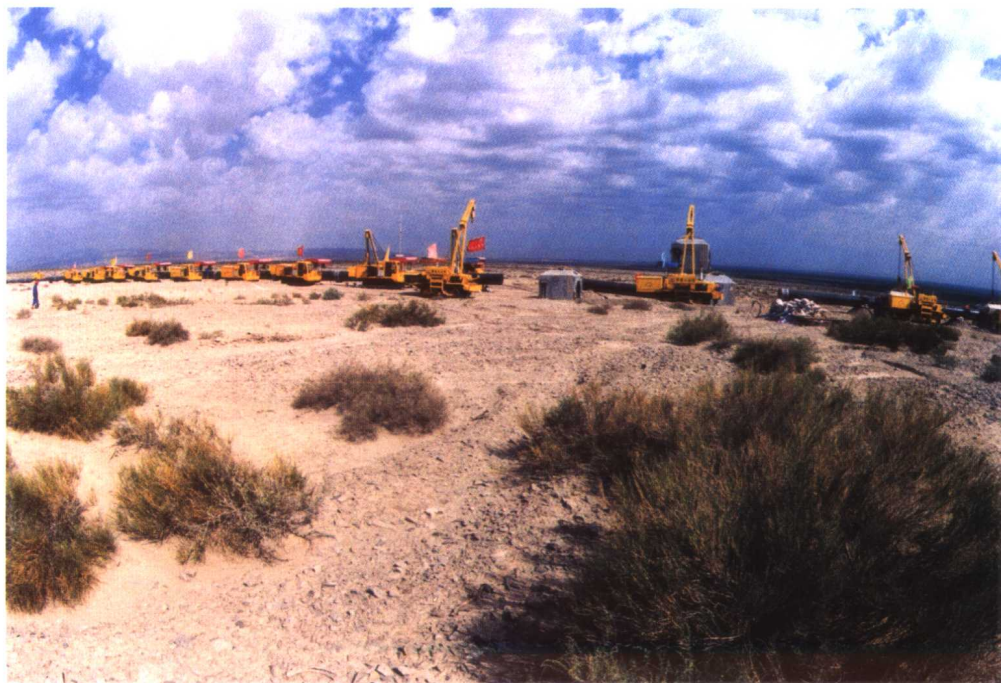
西气东输天然气管道施工场景
