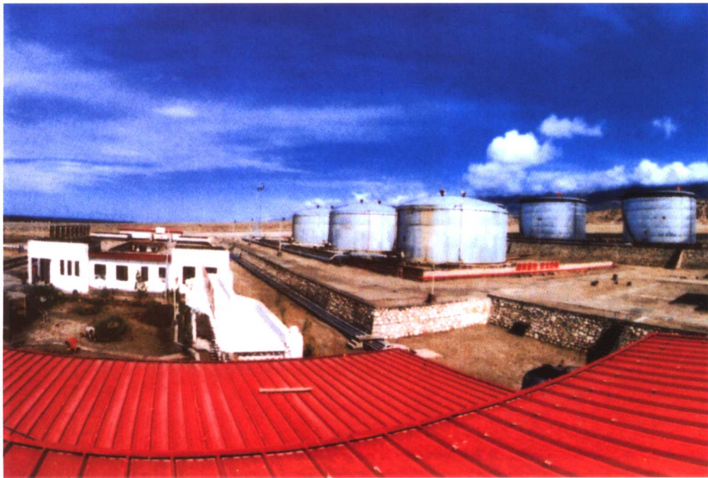
新疆库尔勒至鄯善原油管道为20世纪90年代自动化控制水平最高的管道， 图为南疆库尔勒输油首站
