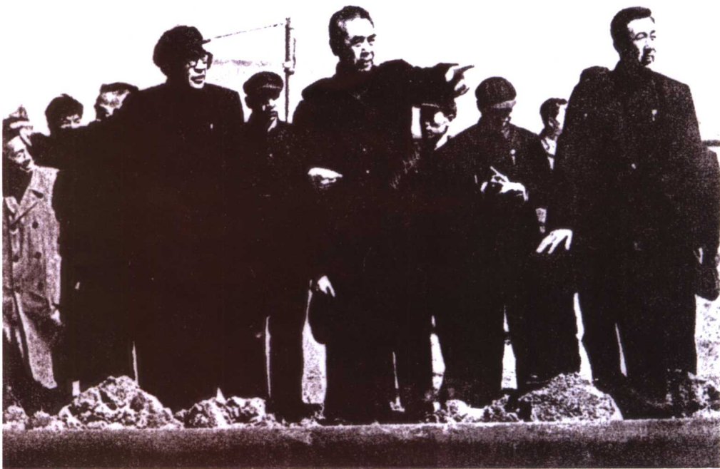
1966年5月,周恩来总理(前左2)第三次视察大庆油田。在康世恩(前左1)、宋振明(前右1)陪同下,视察输油管网建设工地
