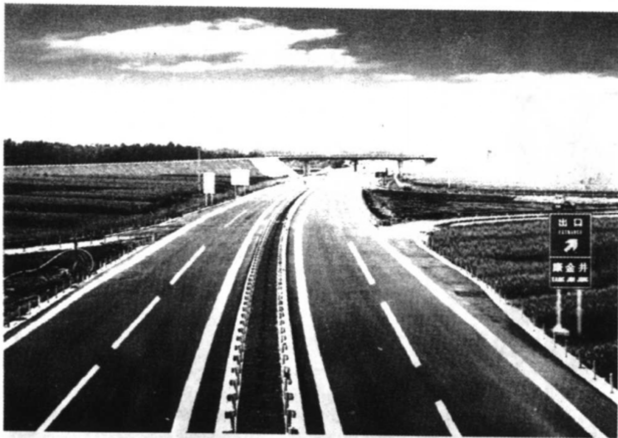
图 1-1 哈绥高速公路 SBS 改性沥青路面
