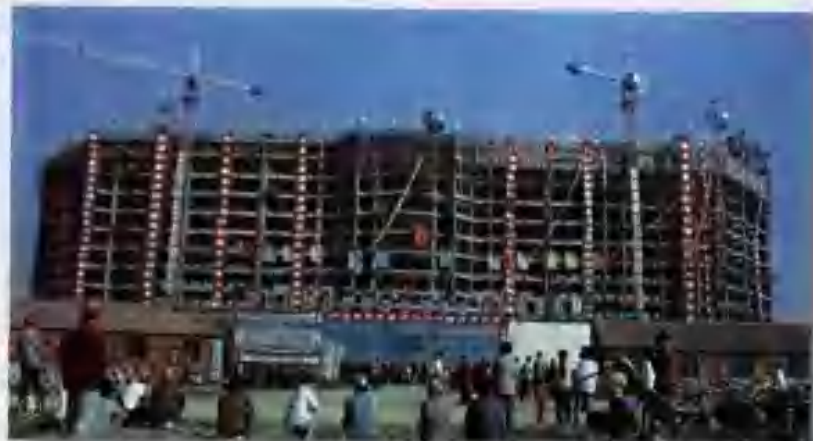
③ 1994年12月大楼主体竣工
