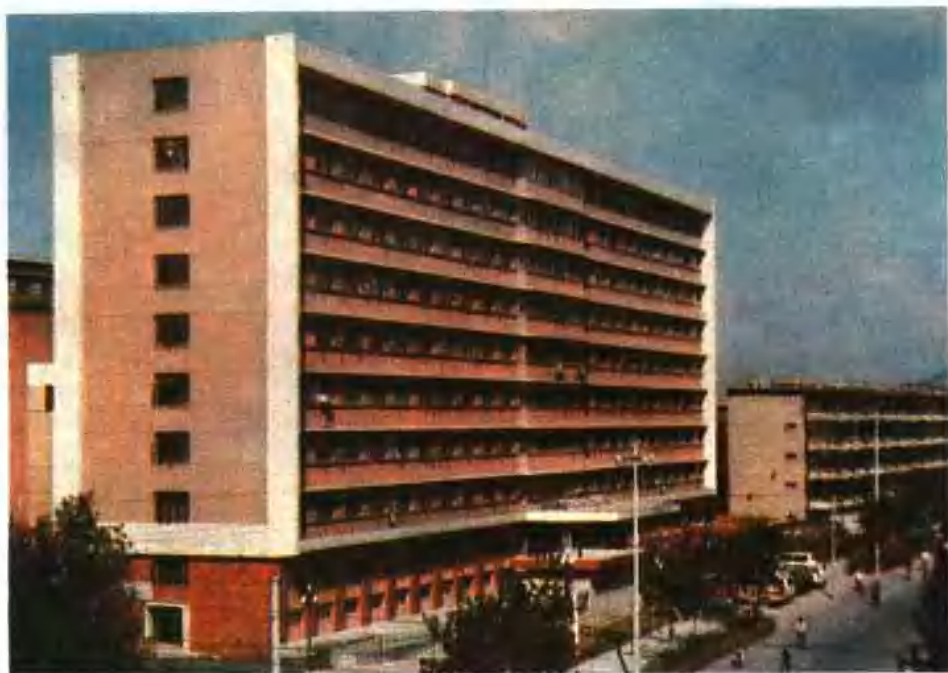
1. 山东省第一轻工业厅大楼
