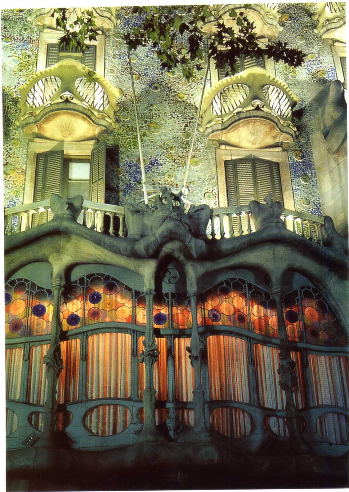
■ 米拉公寓 精致复杂的室外装饰效果，体现了多种材料的综合运用，并显示出高超的工艺水平。
