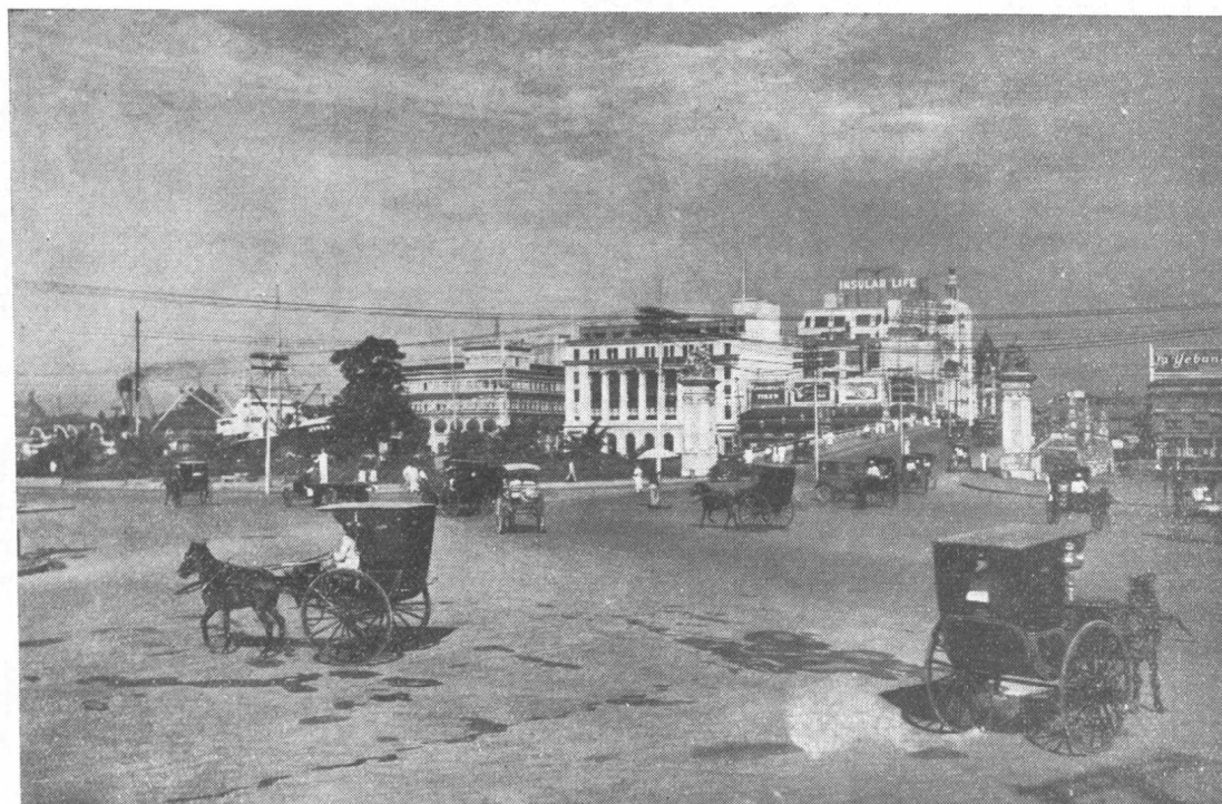
馬 尼 刺 鍾 氏 橋 (Jones Bridge) 附 近 風 景
