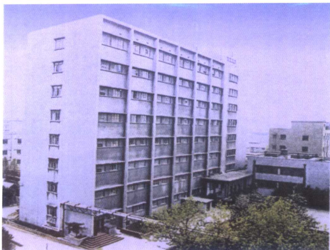
1982 年 上海延安西路 上海生物制品研究所科研楼
