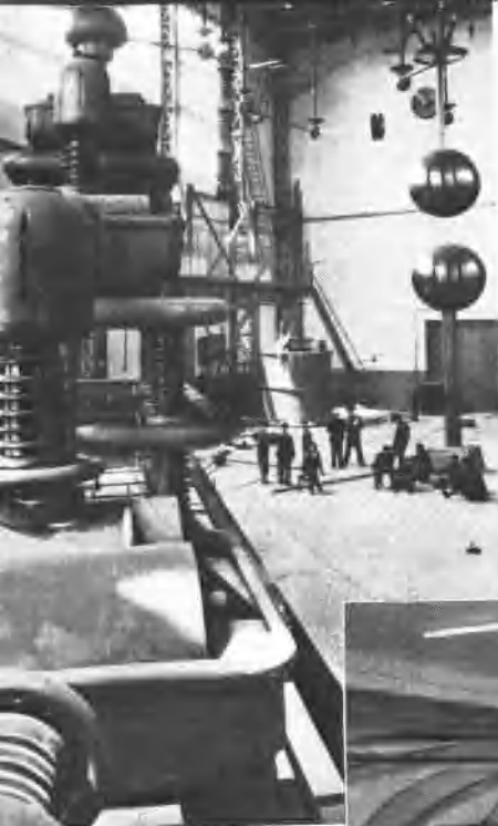
我國最大的高壓試驗室的設備之 ——工頻三級高壓變壓器。
