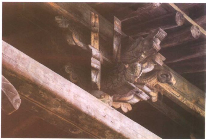
图 5-13 (b) 襄垣南坡村某庙檐下斗拱
