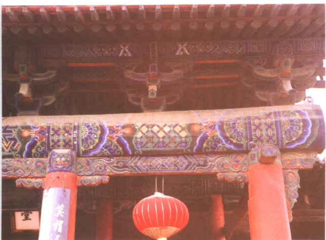
图 3-6 霍州州署大堂抱厦前檐下斗拱
