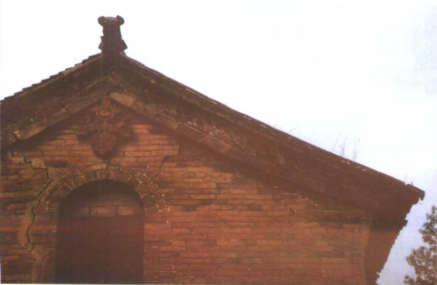
图 5-17b (a) 壶关树掌镇东村某民宅砖悬鱼
