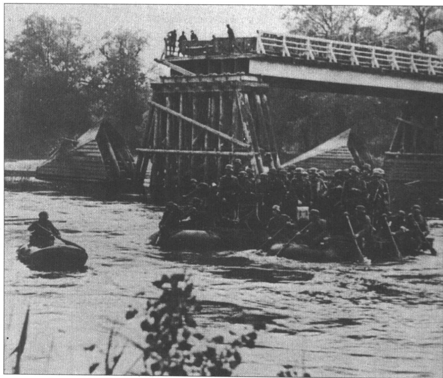
德军士兵正乘橡皮艇渡过苏联的一条小河，工程师正为车辆通行重建桥梁。
