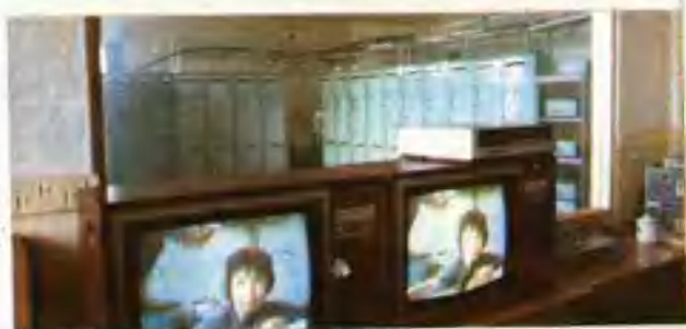
烟台电 视台塔山微 波机房
