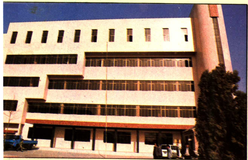
↑ 公司承建的德州无线电三厂厂房获省优质工程奖
