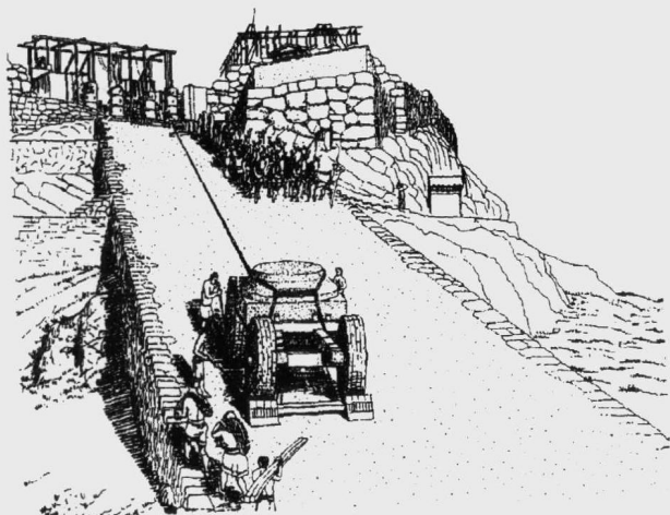
图 1-2 负载马车的提升技术
