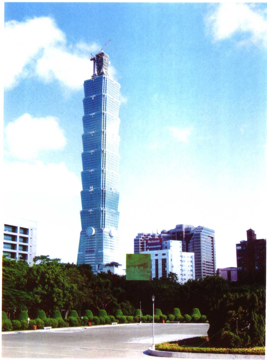
建设中的台北101大楼（作者摄）
