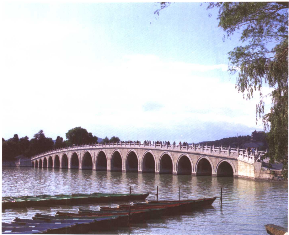
十七孔桥是颐和园中最长的一座桥，它飞跨东堤和南湖岛，长150米，宽8米，仿照著名的卢沟桥建造。桥两边白石栏杆上雕有神态各异的石狮500多只。
