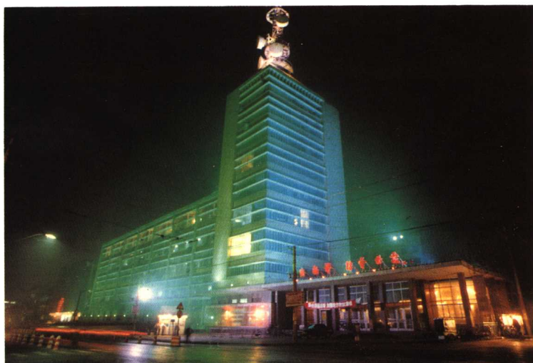
济南第一长途通信枢纽
