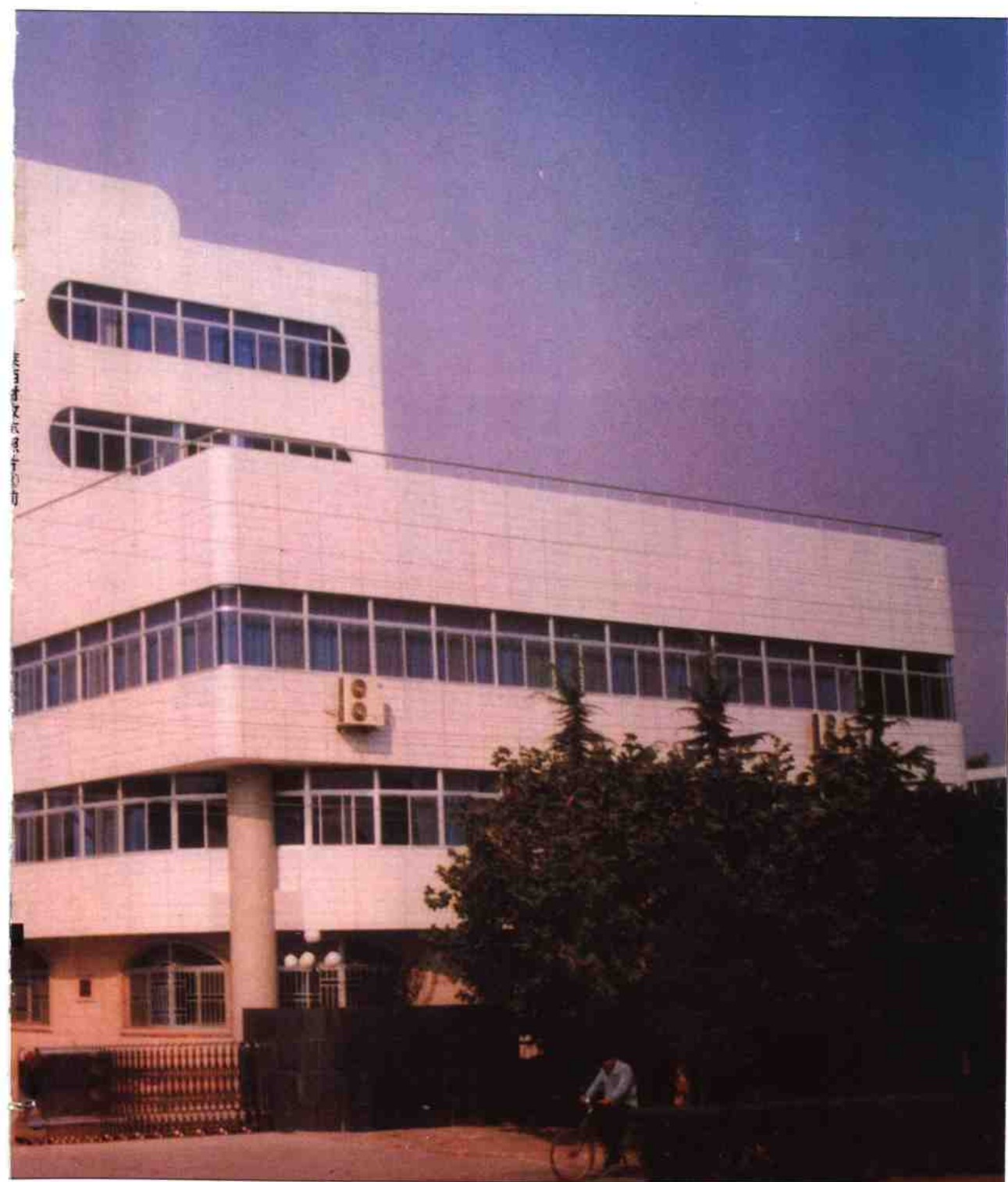
莱西市财政局机关办公楼
