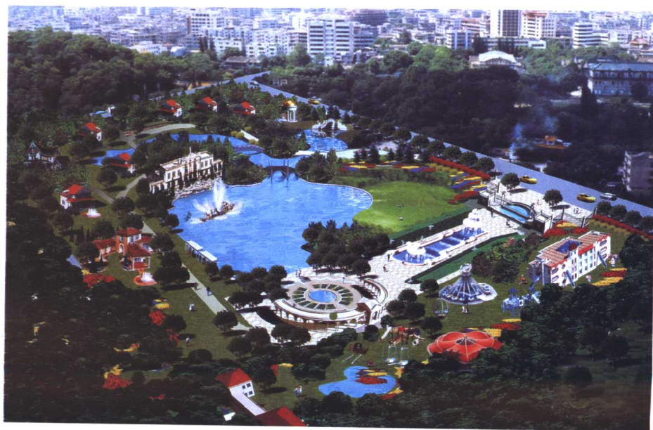
正在兴建的兴海公园
